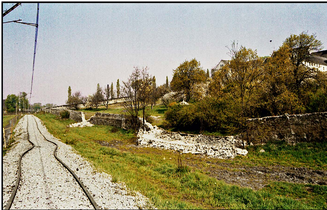
Fot. 1. Centrum niecki osiadań powstałej po katastrofalnych wypływach jesienią 1992 roku. Fot. Jerzy Przybyło. Photo 1. The sinkhole centre that developed after the catastrophic leak in the autumn of 1992. Picture taken by Jerzy Przybyło.
