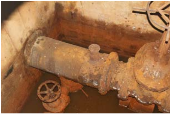
Ryc. 2. Wnętrze studni spustowej solanki (Krakowiak i in., 2013) Fig. 2. Interior of a brine drain chamber (Krakowiak et al., 2013)
