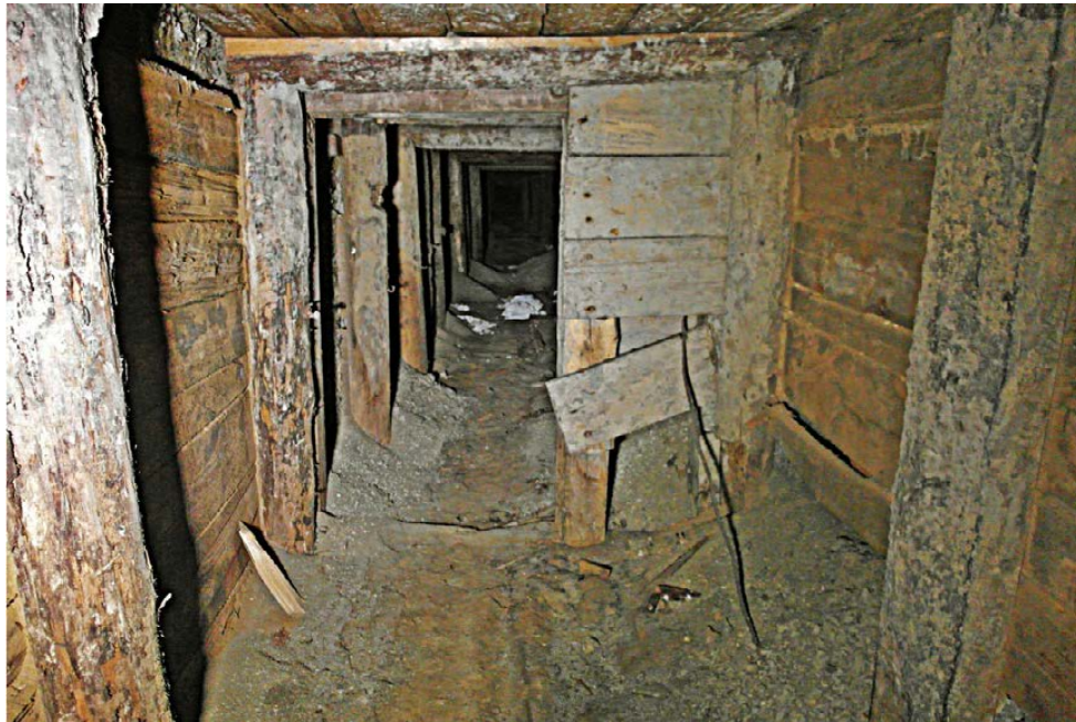
Ryc. 14. Południowy odcinek poprzeczni Colloredo 2. Stan na listopad 2014.
