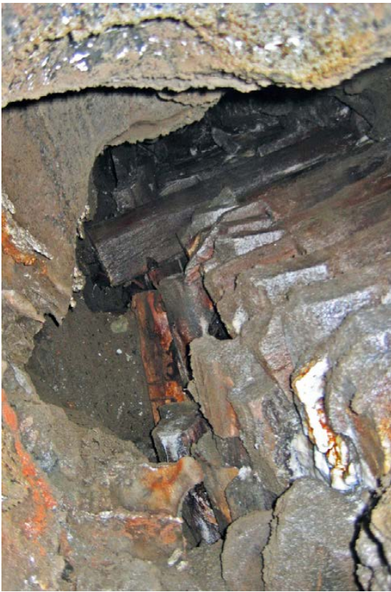
Ryc. 13. Fragment szybu Regis na odcinku poniżej IV poziomu. Rozługowania górotworu powstałe w wyniku działania nienasyconych wód w czasie katastrofy wodnej z lat 1868-1879. Stan na lipiec 2004. Fot. J. Przybyło.
