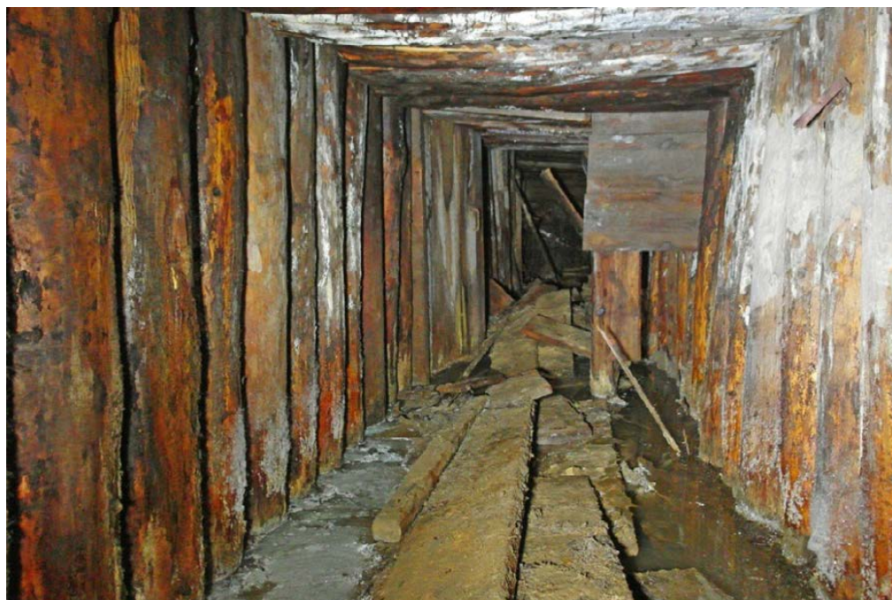
Ryc. 7. Północny odcinek poprzeczni Colloredo 2. Stan na listopad 2014. Wyrobisko jest obecnie zlikwidowane zaczynami uszczelniającymi. Fot. J. Przybyło. Fig. 7. The northern section of the Colloredo 2 cross-corridor. Status of November 2014. The working has been plugged by sealing mixes. Photograph by J. Przybyło.
