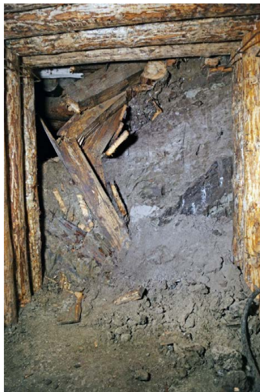
Ryc. 15. Poprzecznia Kloski w trakcie przebudowy. Widoczne namuły naniesione wodami wypływu w poprzeczni w latach 1868-1879. Stan na listopad 2016. Wyrobisko jest obecnie zlikwidowane zaczynami uszczelniającymi. Fot. J. Przybyło.
