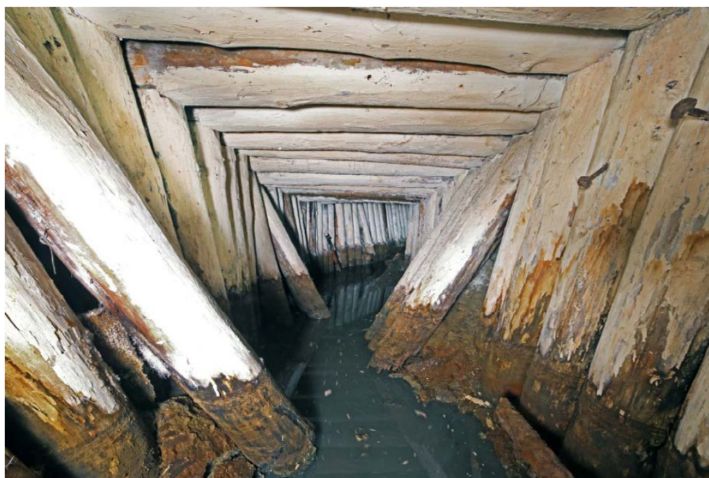
Ryc. 8. Chodnik podłużny poprowadzony z poprzeczni Kłoski do szybika Albrecht. Stan na luty 2017. Chodnik jest obecnie zlikwidowany zaczynami uszczelniającymi. Fot. J. Przybyło. Fig. 8. Level corridor conducted from the Kłoski cross-corridor to the Albrecht level-connecting shaft. Status of February 2017. The corridor has been plugged by sealing mixes. Photograph by J. Przybyło.
