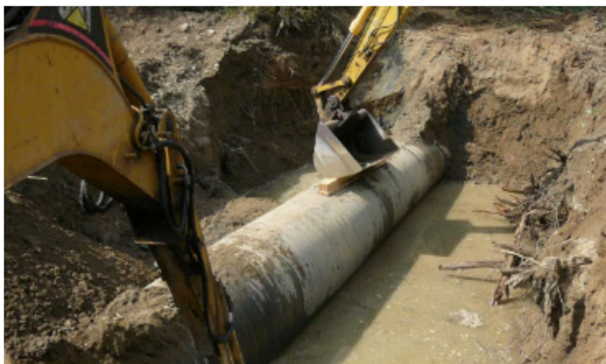
Rys. 1. Ponowne posadowienie kolektora PE DN1400 w Nowym Sączu po ustąpieniu powodzi (fot. Kazimierz Kudlik) [7]
