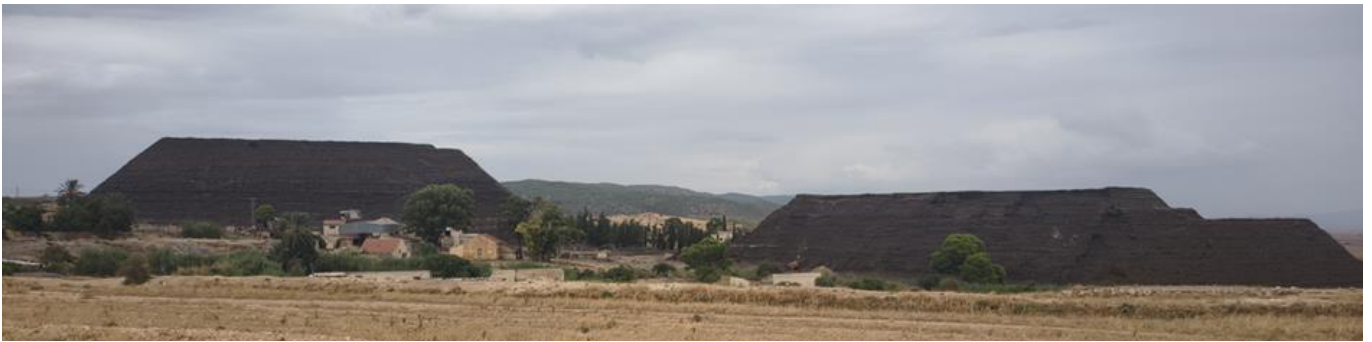
Ryc. 3. Hałdy odpadów poflotacyjnych w rejonie nieczynnej kopalni rud cynku i ołowiu przy strukturze solnej El Akhouat. W tle masyw struktury solnej Ech Cheid. Lokalizacja na Ryc. 1.
